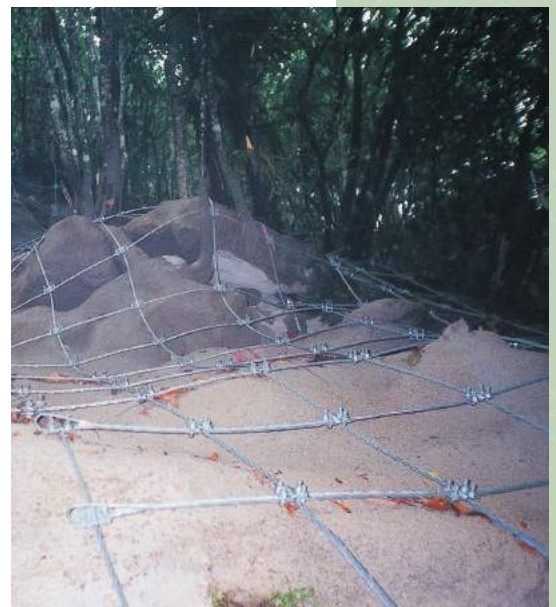
亜鉛アルミ仕様の現場
